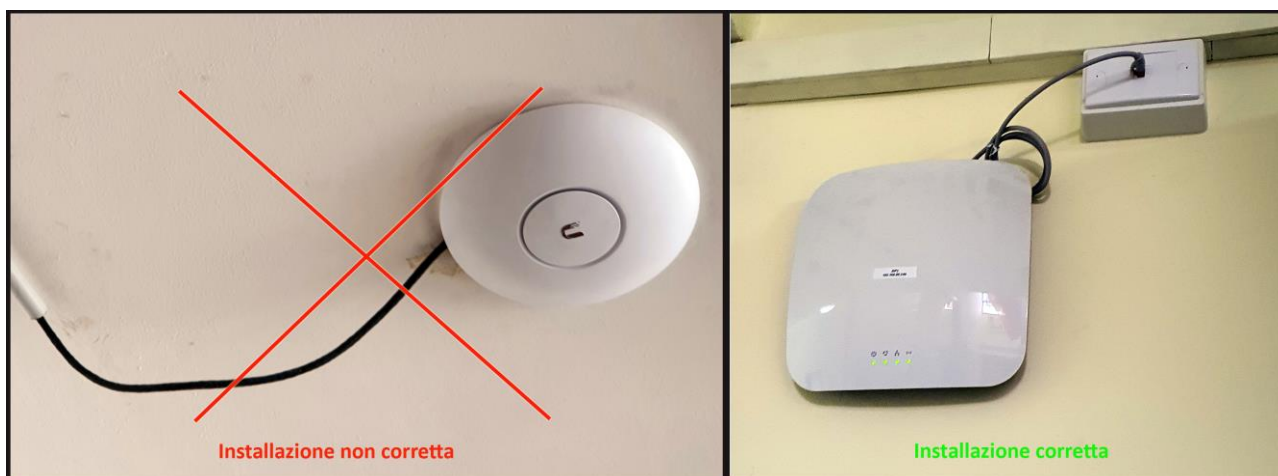
Figura 10 – Installazione corretta dell'Access Point
